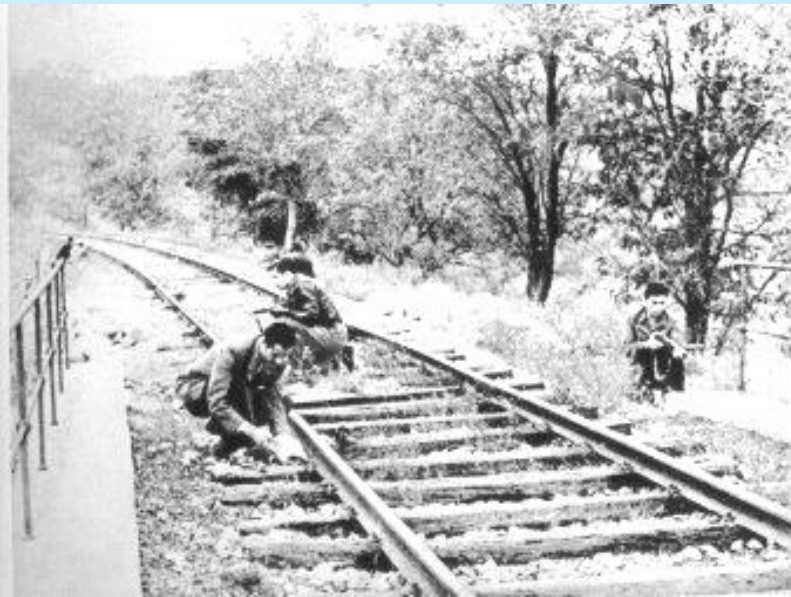
Sabotage d'une voie ferrée
