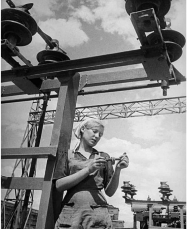
Ouvrière dans une centrale électrique, 1931, Max Penson
