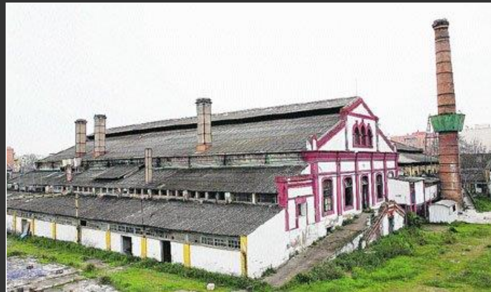
Ancienne verrerie de la Trinité, à Séville
