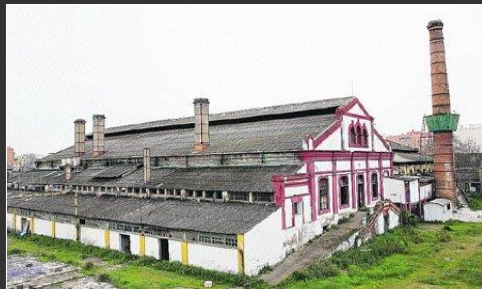
Antigua fábrica de vidrio en la Trinidad, Sevilla
