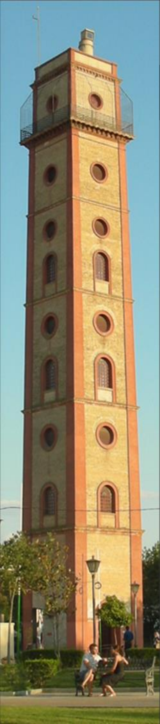
Tour des « Perdigones ». Une usine de plomb, Séville
